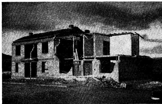
FIG. 4. — Constructions en brique (pièrres) avec quelques renforcements en béton armé. Effet d'une poussée latérale (Tchan).
